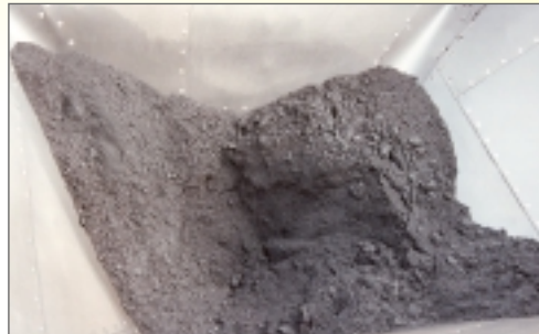
Tiefbunker für Feinkohle: Durch die gleitfördernde Auskleidung fließt das Material ohne Anbackungen und Verstopfungen gleichmäßig ab.
