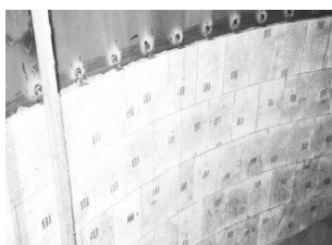
Die Abbildung zeigt einen Gichtgaswirbler mit ca. 330 m 2 KALCOR in einem europäischen Stahlwerk.
