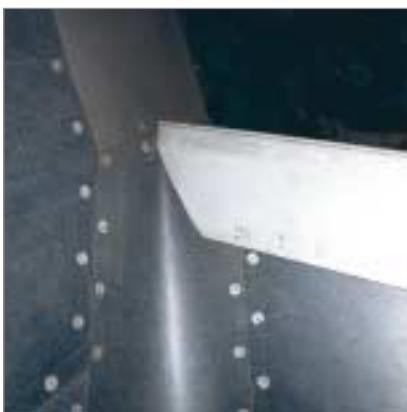
KALINOX Winkel schützen den Sattel des mit KALEN ausgekleideten Bunkers.
