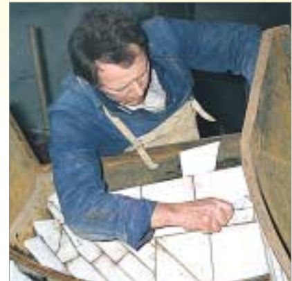
Rutschen mit KALCERAM Auskleidung sind eine dauerhafte Lösung, z.B. für Sackverladeanlagen in Zementwerken.
