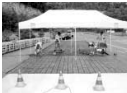
Montage der Teststrecke mit Schmelzbasalt ABRESIST.
