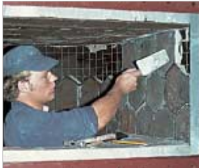
ABRESIST-Verschleißschutz für einen Zyklon in der Zementindustrie. Das Wellengitter auf den Stahlflächen ermöglicht eine betriebssichere Befestigung. Temperaturen von ca. 250 °C erfordern den Einbau mit Wasserglaskitt.
