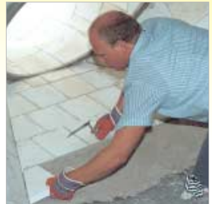
Sammeltrichter in der Sinterentstaubung mit KALOCER.
