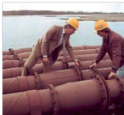
Dehnungsstück in einer hydraulischen Ascheleitung.
