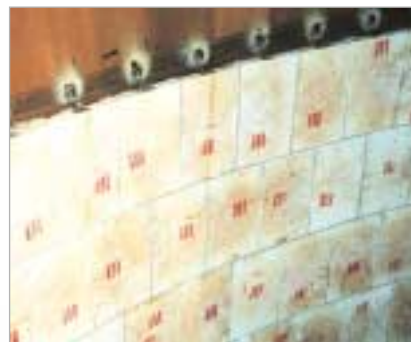
Hochtemperatur-Verschleißschutz – Entstaubungszyklon in einem Hochofenwerk in Europa.
