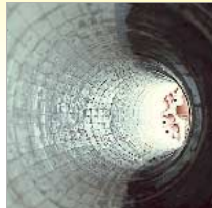
Kombinierte Auskleidung mit ABRESIST und KALOCER.
